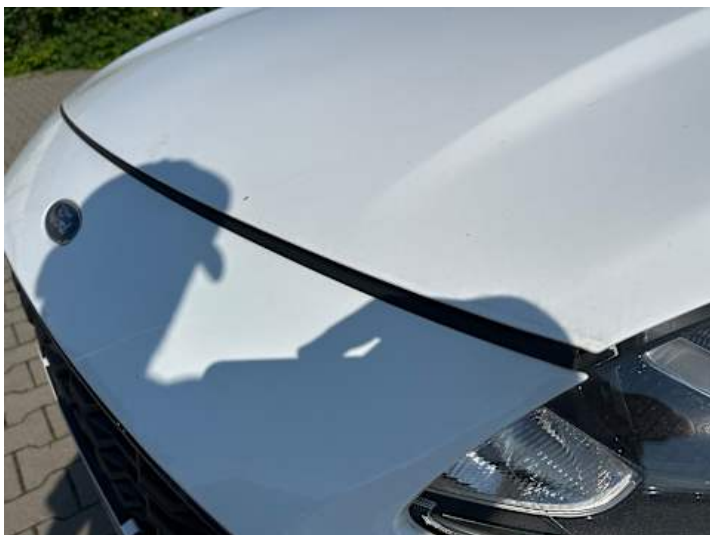
Motorhaube (Spaltmaße ungenau)
