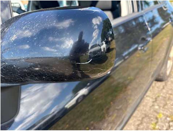
Fahrtür (Kratzer, Rost)
