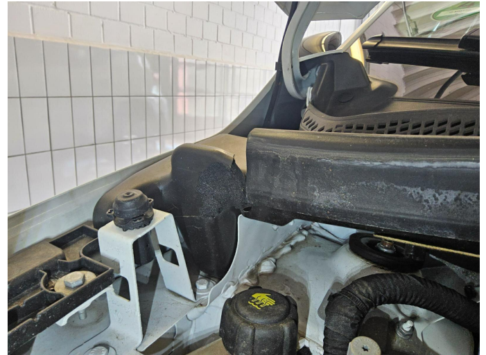
Bild 6: Technik, Schaumstoff Windabweiser, Tierverschiss, erneuern
