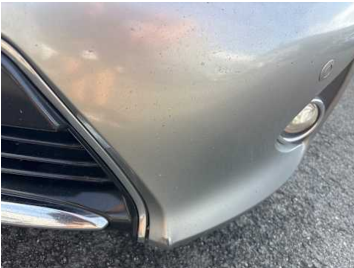
Stoßstange vorne (Unsachgemäß instand gesetzt)
