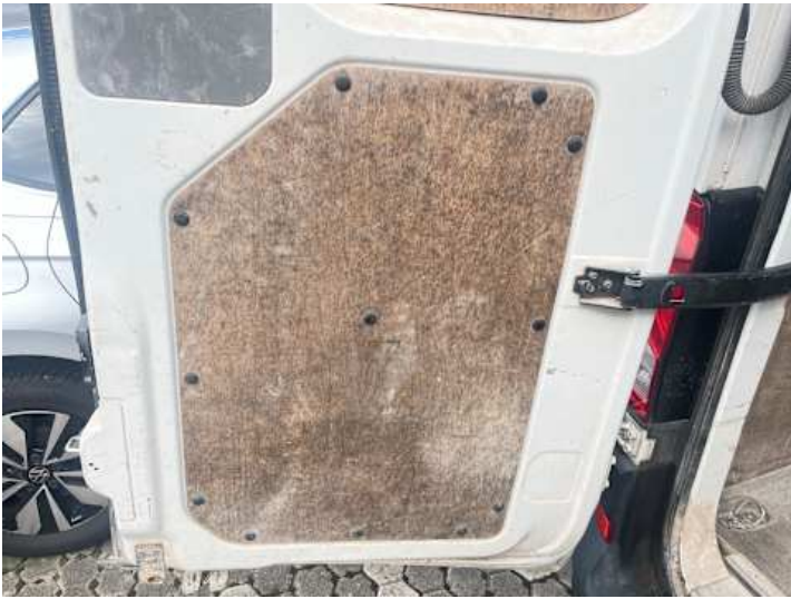
Innenraum (Diverse Schäden)
