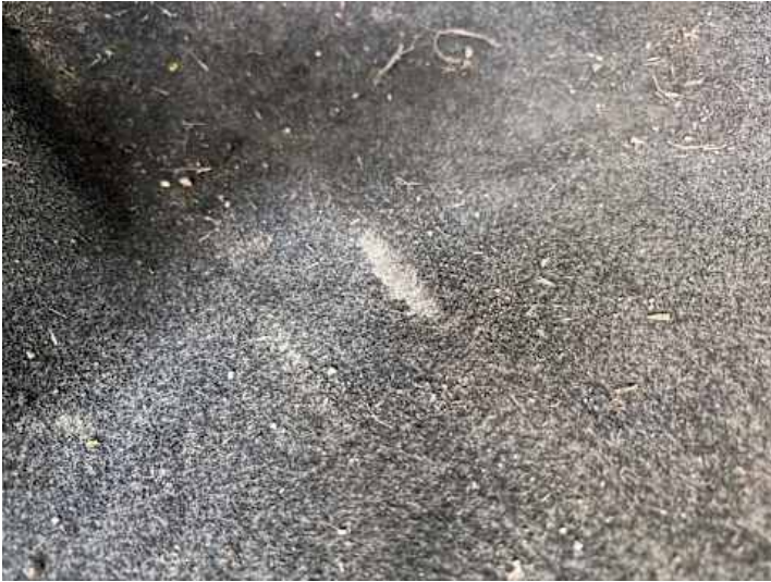
Innenraum (Diverse Schäden)
