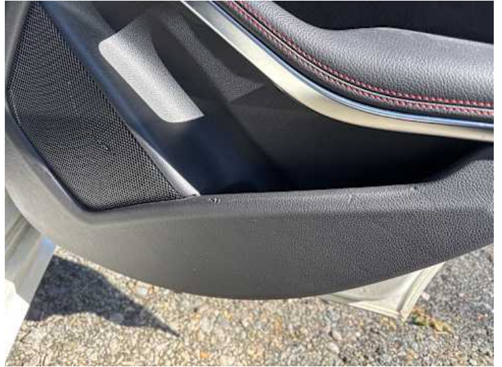
Innenraum (Diverse Schäden)
