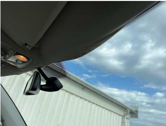
Innenraum (Anderer Schaden): Dachhimmel lose
