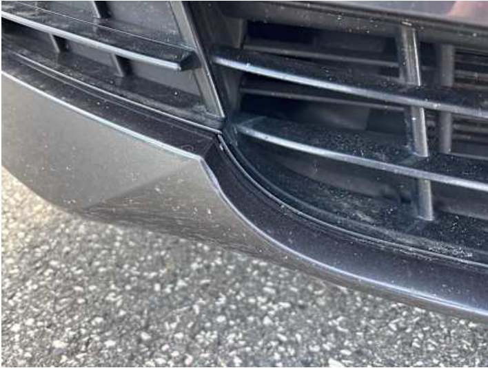
Stoßstange vorne (Verformung)
