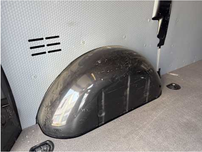
Innenraum (Diverse Schäden)
