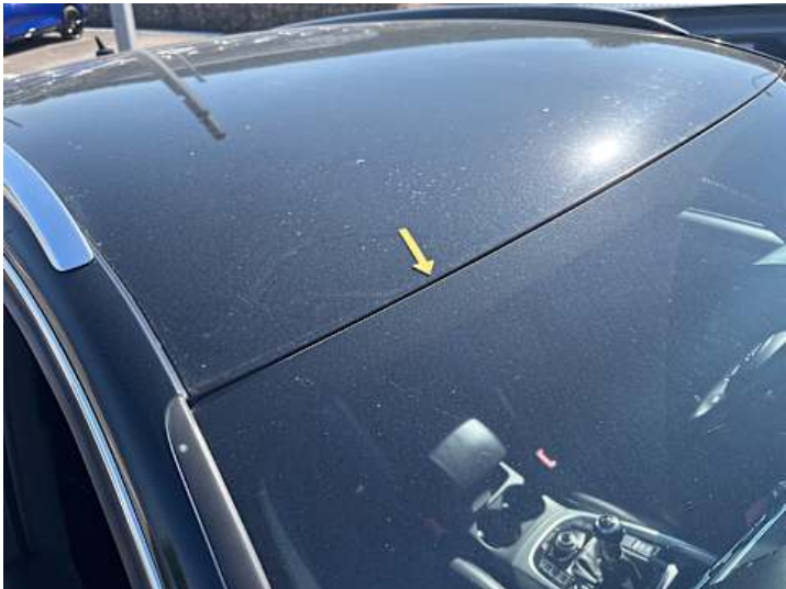
Dach (Steinschlag, Rost)
