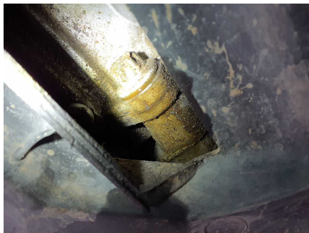
Beschädigung 9: Getriebe: Verteilergetriebe - undicht - Diagnose durchführen
