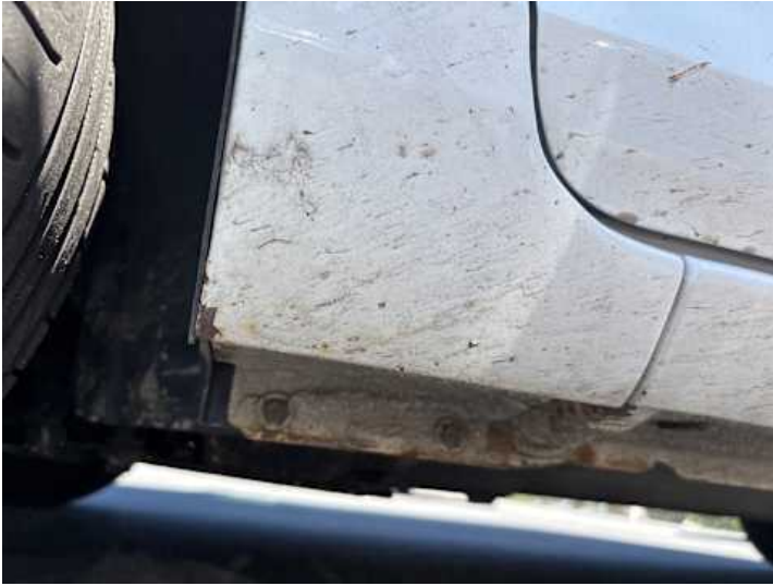
Kotflügel vorne links (Rost)
