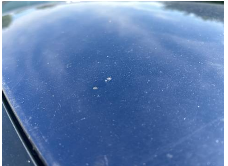
Dach (Lackschaden, Steinschlag)
