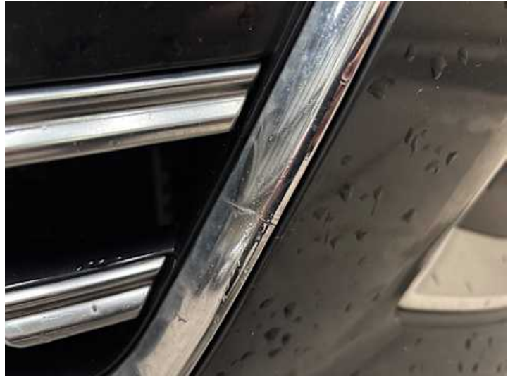
Stoßstange vorne (Riss/Bruch)
