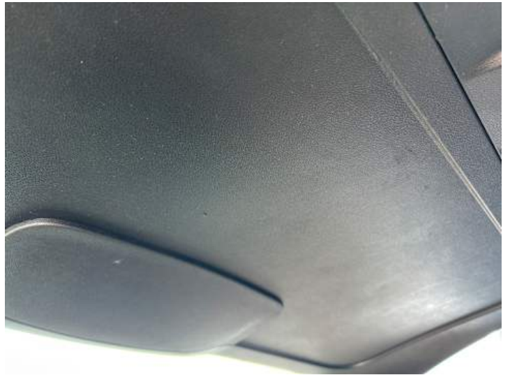
Innenraum (Diverse Schäden)
