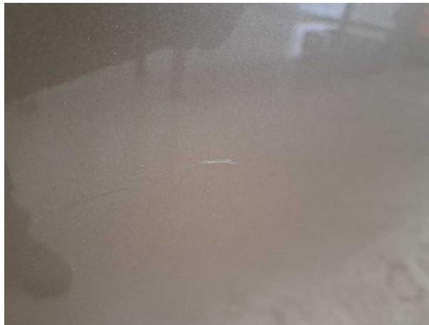
Schiebetür links: Schiebetür mit Glasscheibe - Delle / Lackschaden - instandsetzen und lackieren
