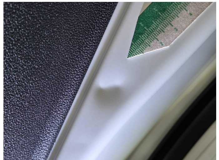
Bild 8: Außen, Tür hinten rechts - Türrahmen, eingedellt, drücken
