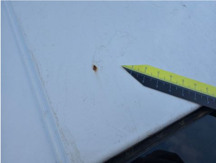
Dach (Rost, Lackschaden)
