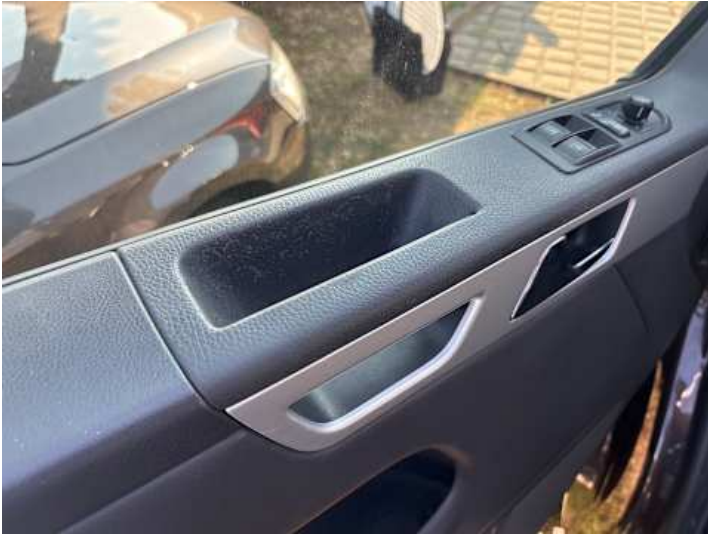
Innenraum (Diverse Schäden)
