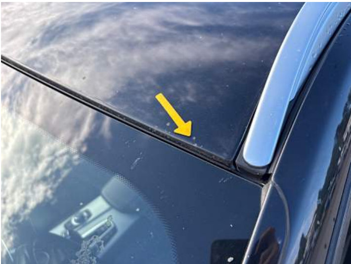
Dach (Lackschaden, Rost)
