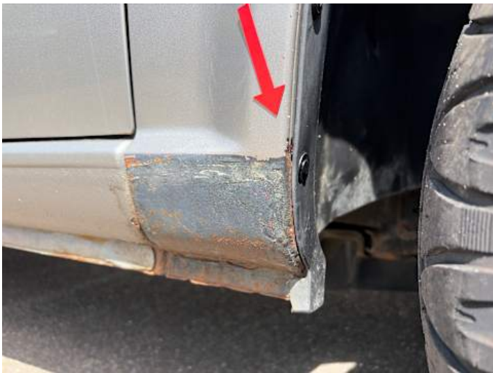
Kotflügel vorne rechts (Rost, Kratzer)
