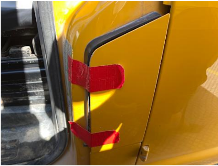
Türe hinten links (Unsachgemäß instand gesetzt)
