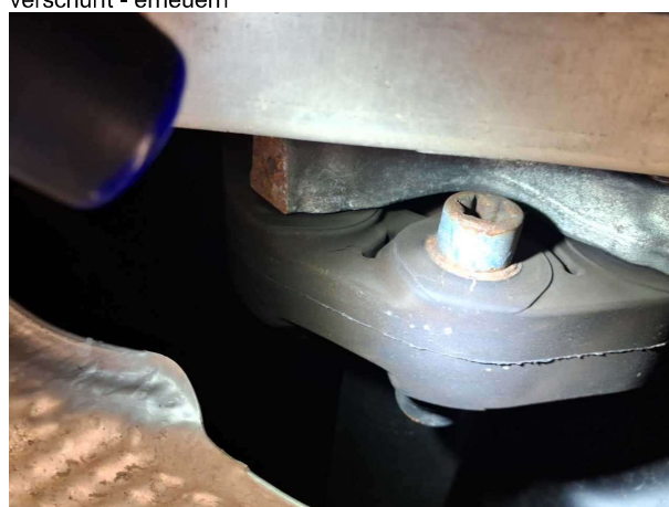
Beschädigung 8: Sonstiges: Sonstiges (Hardyscheibe) - porös / rissig - erneuern
