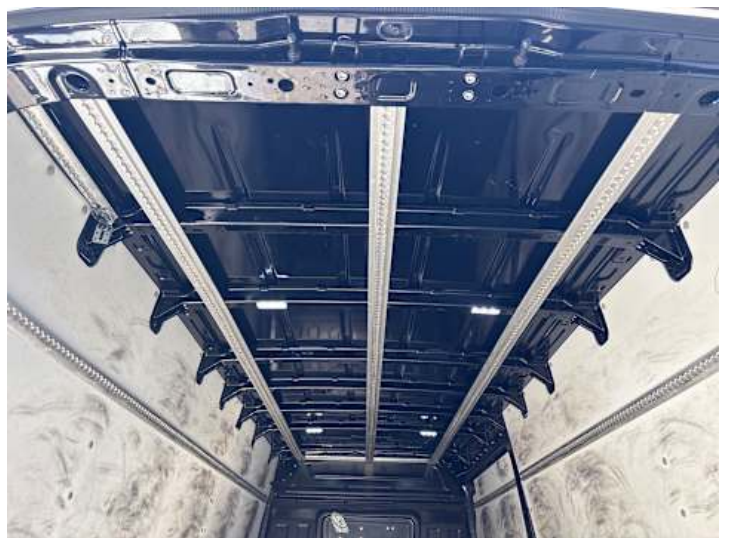
Innenraum (Kratzer, Diverse Schäden)
