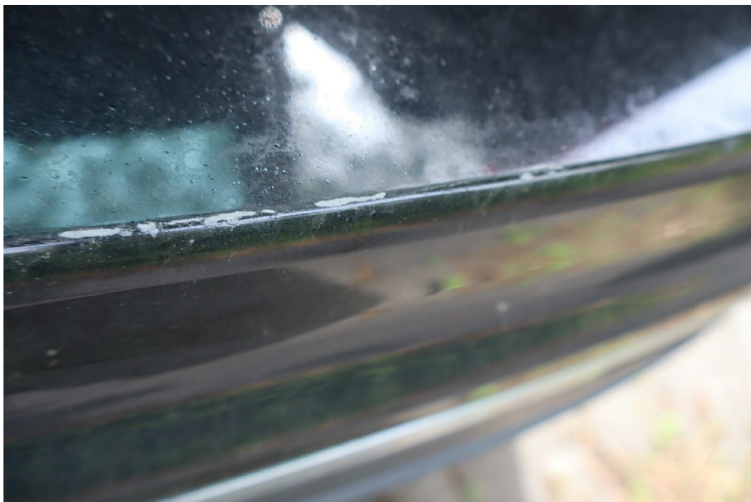
Bild 7 : Stoßfängerverkleidung hinten Ladekante verschrammt
