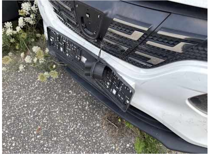
Stoßstange vorne (Verformung, Riss/Bruch)
