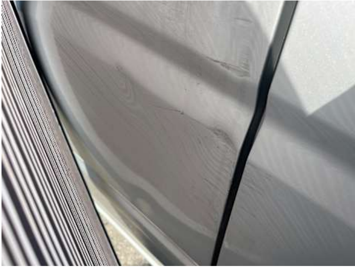
Türe hinten rechts (Verformung)
