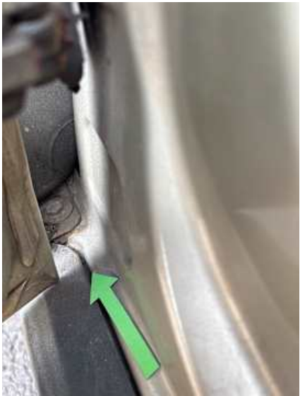
Schweller links (Rost)
