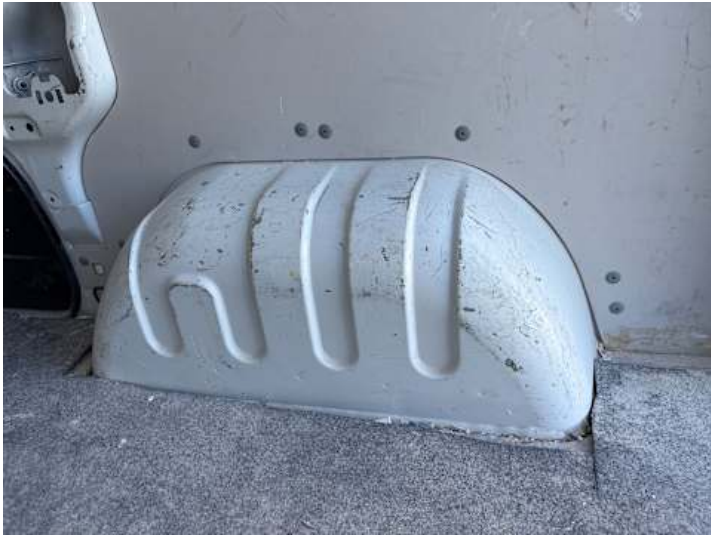
Innenraum (Diverse Schäden)
