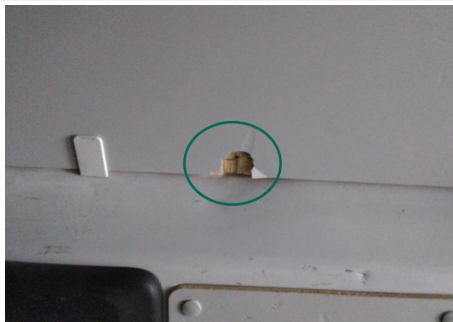
Innenverkleidung Laderaum / Oben Vorne Rechts / Gebrochen
