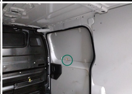
Innenverkleidung Laderaum / Oben Vorne Rechts / Gebrochen
