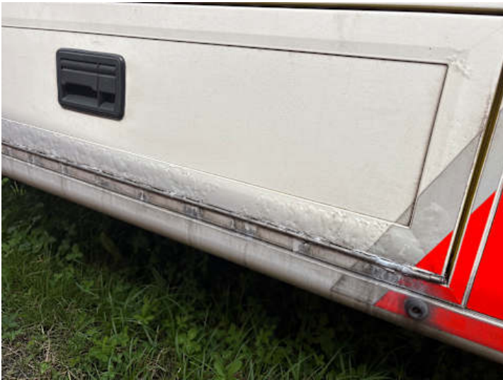
Seitenteil hinten links (Rost)
