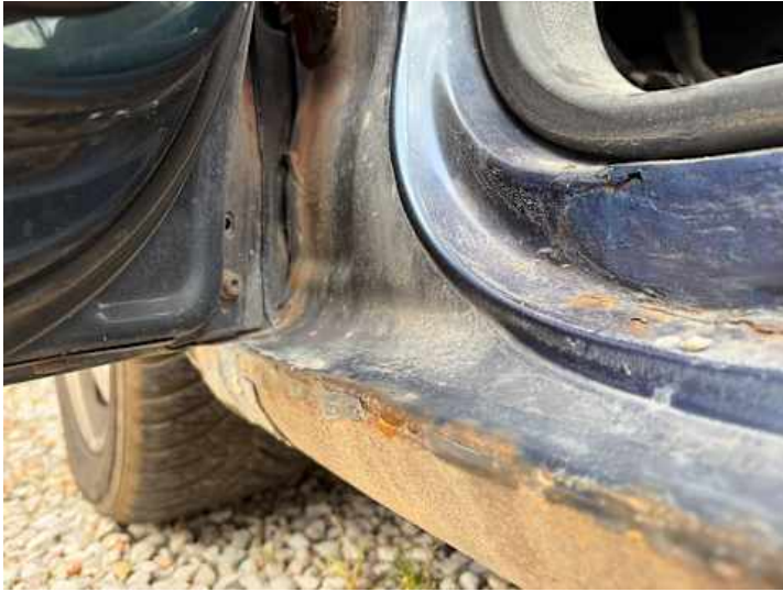
Schweller links (Rost)
