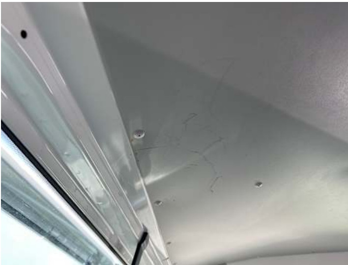
Innenraum (Kratzer, Riss/Bruch)
