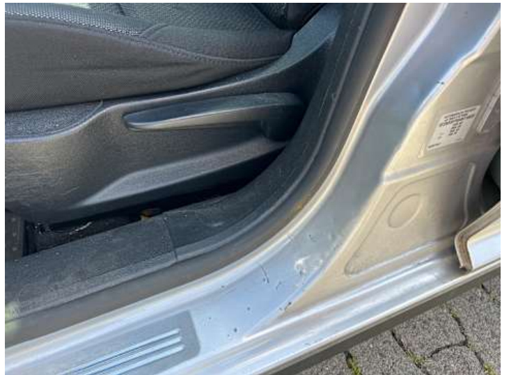
Fahrtür (Delle, Kratzer)
