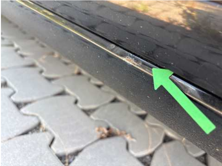
Schweller rechts (Rost)
