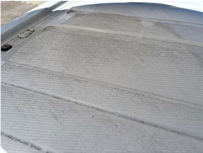
Dach (Delle, Lackschaden, Steinschlag, Verformung)
