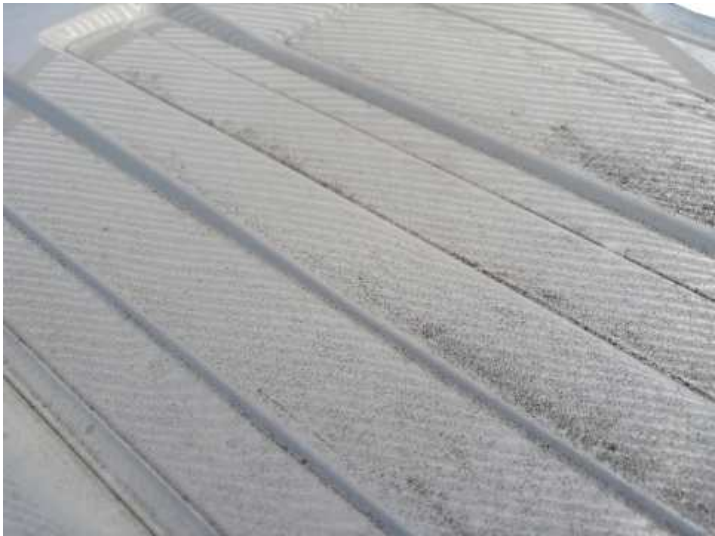
Dach (Delle, Lackschaden, Steinschlag, Verformung)
