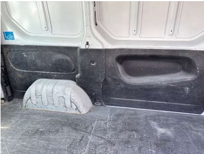
Innenraum (Verschmutzung, Kratzer, Verschleiß, Riss/Bruch, Nicht vorhanden)
