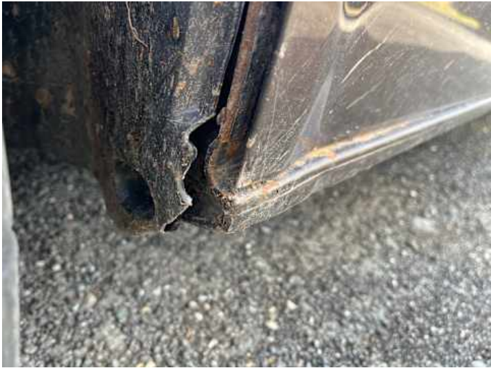
Schweller links (Rost)
