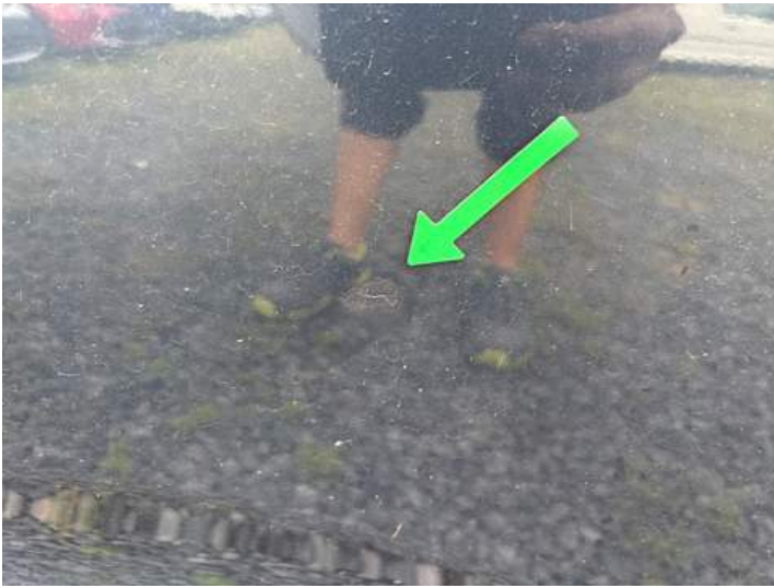
Beifahrertür (Unsachgemäß instand gesetzt)
