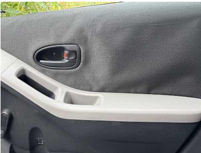
Innenraum (Diverse Schäden)
