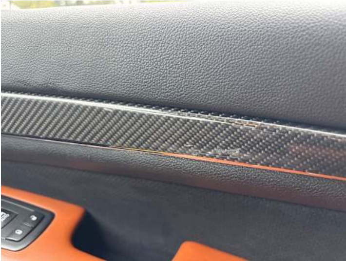
Innenraum (Riss/Bruch, Diverse Schäden)
