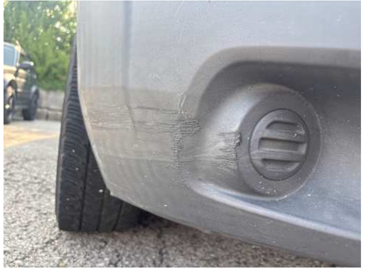
Stoßstange vorne (Kratzer, Spaltmaße ungenau)
