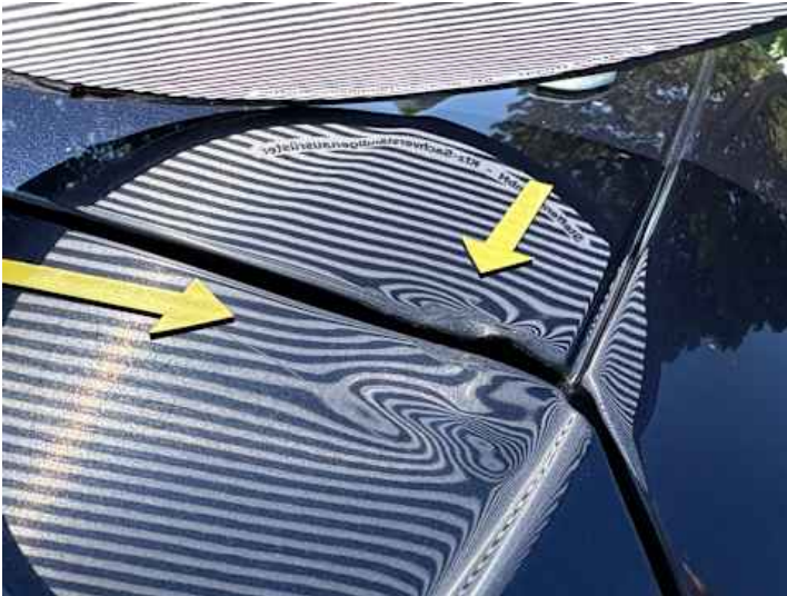
Dach (Unsachgemäß instand gesetzt, Verformung, Lackschaden, Rost)
