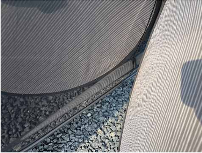
Türe hinten rechts (Delle)
