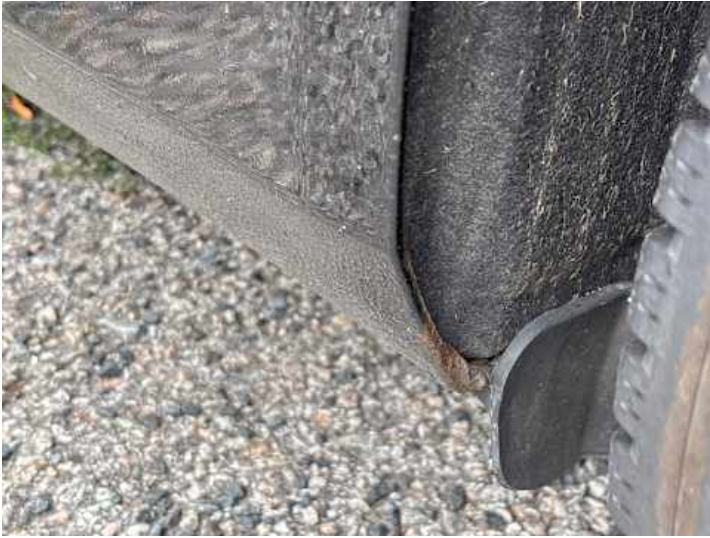
Seitenteil hinten links (Rost)
