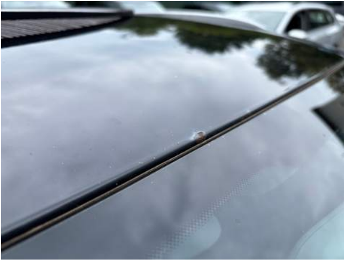
Dach (Rost, Steinschlag)
