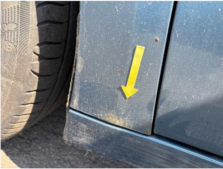
Kotflügel vorne links (Rost)
