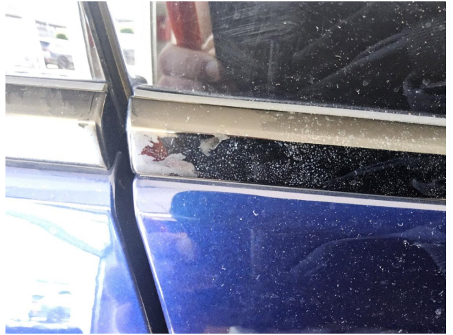
Alle 6 Fensterschaftleisten außen, verfärbt (DEKRA)
