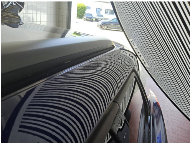
Dachrahmen links, eingedellt, drücken (DEKRA)
