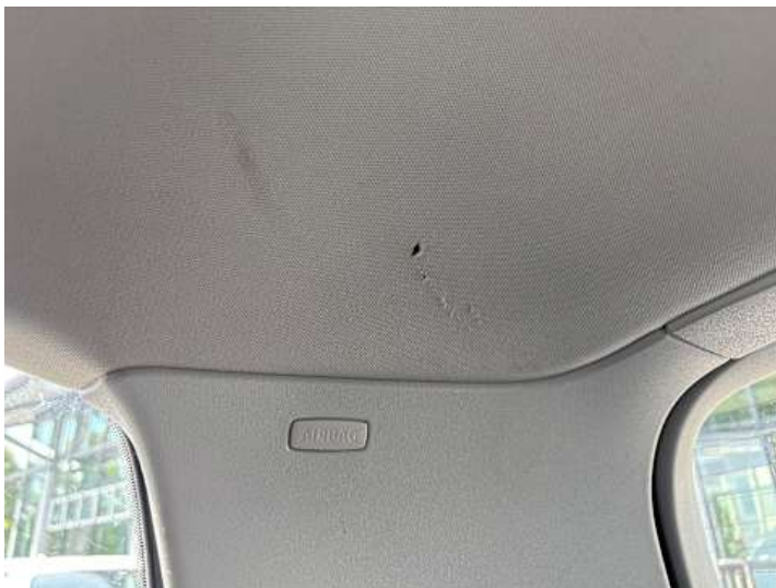
Innenraum (Verschmutzung, Verschleiß)
