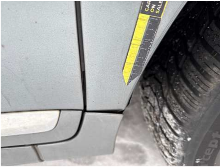
Kotflügel vorne rechts (Spaltmaße ungenau)
