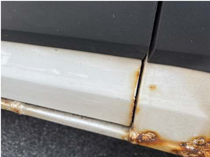
Türe hinten links (Rost)
